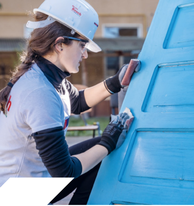
Takım oluşturmaktan takım ruhuna: Cluj'daki restorasyon ve modernizasyon çalışmalarına yardımcı olan 200 kişiden 1'i.
